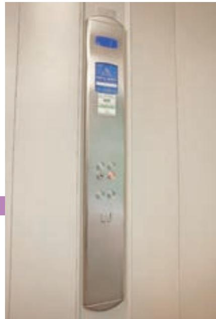
Le finiture delle pareti di cabina dipendono dalle caratteristiche dell'ambiente di lavoro e dalle condizioni di utilizzo. La lamiera può subire un trattamento speciale a resine epossidiche, può essere rivestita con materiali speciali e con diverse colorazioni, anche per utilizzi in ambienti chimici ed alimentari. Le buttoniere si caratterizzano per semplicità d'uso e mantengono affidabilità nel tempo.
